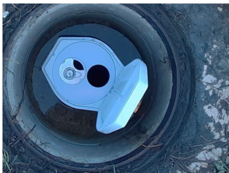
Messstelle Unterflur mit Zwischenring
